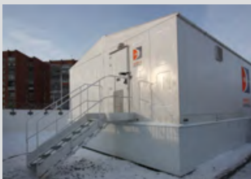
Рис. 13.4. Двухмодульная модульная совмещенная компоновка КРУМ
