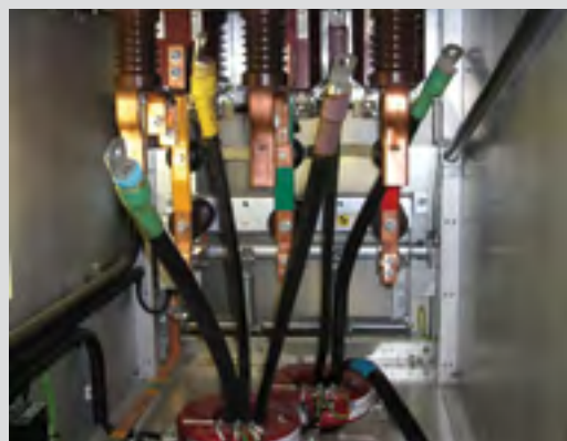
Рис. 5.15. Отсек присоединений
