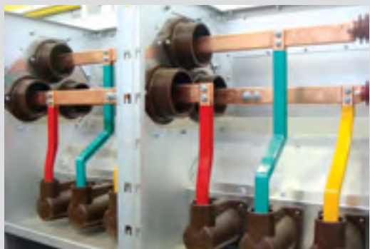
Рис. 5.10. Отсек сборных шин на этапе сборки КРУ
