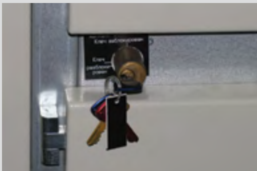
Рис. 10.4. Замковая блокировка шкафа ввода
