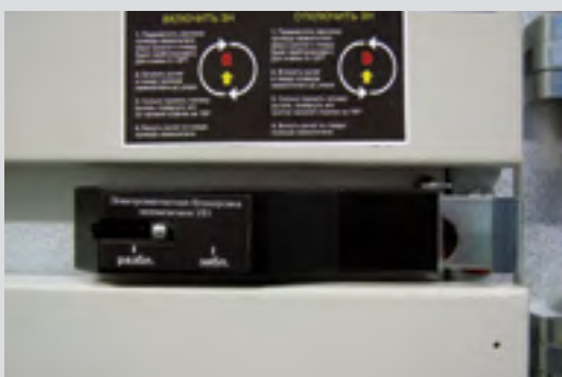
Рис. 10.7. Электромагнитная блокировка привода заземлителя
