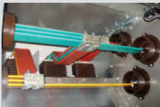
Рис. 7.7. Сегрегация со смежными шкафами КРУ
