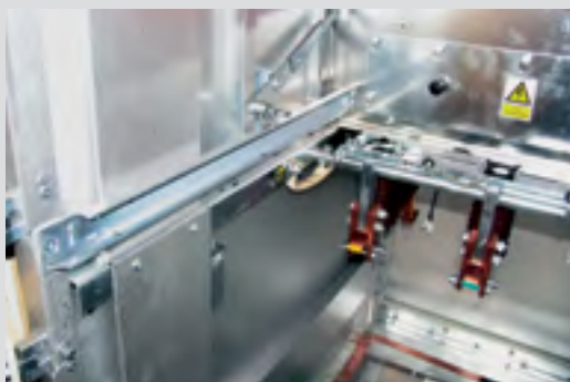
Рис. 7.9. Отсек присоединений при демонтированной перегородке
