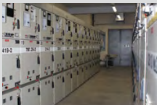
Рис. 12.4. Двухрядное расположение шкафов КРУ
