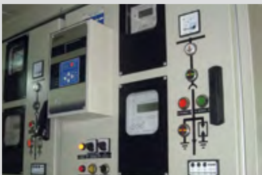
Рис. 7.23. Фасад релейного отсека
