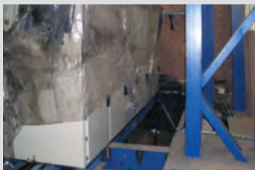
Рис. 12.2. Размещение шкафов двухстороннего обслуживания
