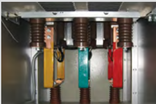
Рис. 7.22. Вывод шинами назад через приставку
