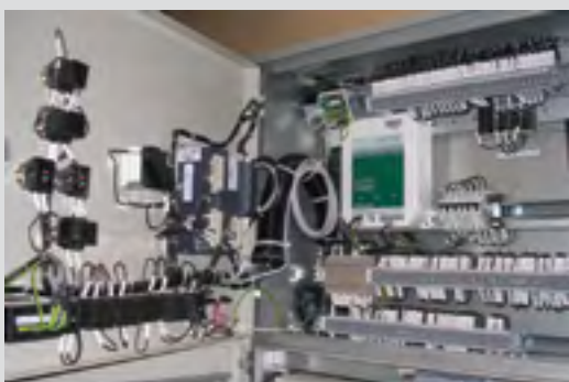
Рис. 7.24. Релейный отсек (вид при открытой двери)
