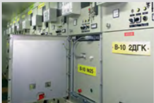
Рис. 5.11. Экраны дверей высоковольтных отсеков
