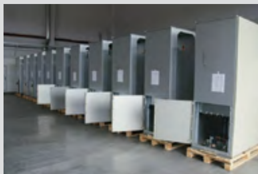
Рис. 7.19. Шкаф КРУ двухстороннего обслуживания.
