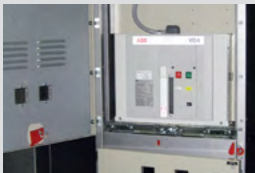
Рис. 7.3. КВЭ в контрольном положении
