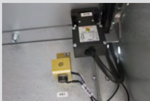
Рис. 11.7. Двухступенчатая дуговая защита
