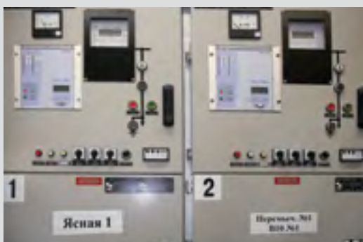
Рис. 9.2. Шкаф КРУ с МПЗ типа SPAC
