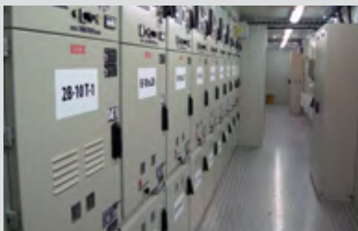
Рис. 13.1. Шкафы KPU в составе КРУМ SKP
