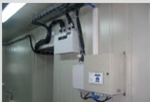
Рис. 11.6. Размещение логического устройства в отдельном шкафу
