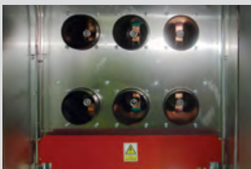
Рис. 7.8. Шторочный механизм в отсеке КВЭ
