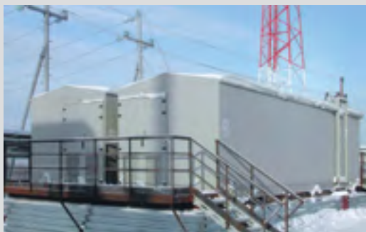
Рис. 13.3. Параллельная компоновка КРУМ
