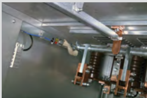
Рис. 11.4. Оптический датчик в отсеке присоединений
