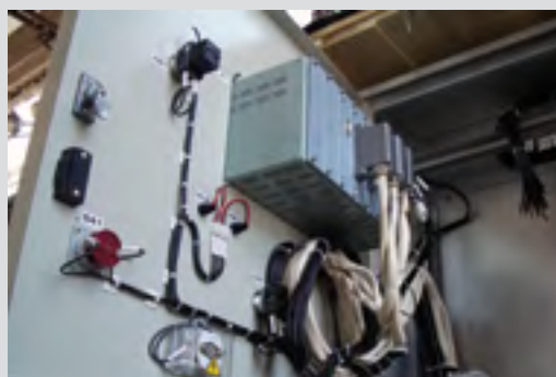
Рис. 11.5. Размещение управляющего терминала на двери отсека
