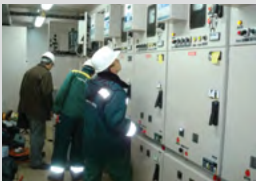
Рис. 18.3. Пуско-наладочные работы
