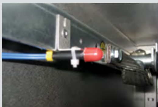
Рис. 5.12. Оптический датчик дуговой защиты
