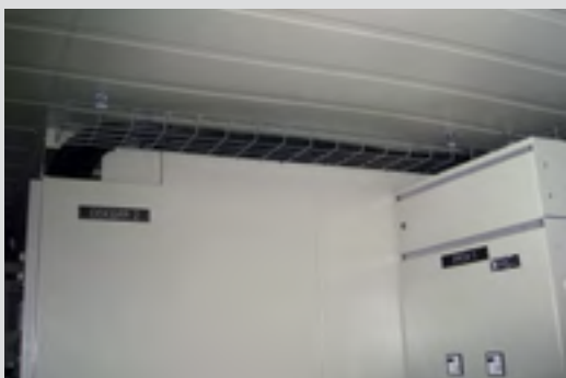
Рис. 7.25. Пример прокладки контрольных кабелей
