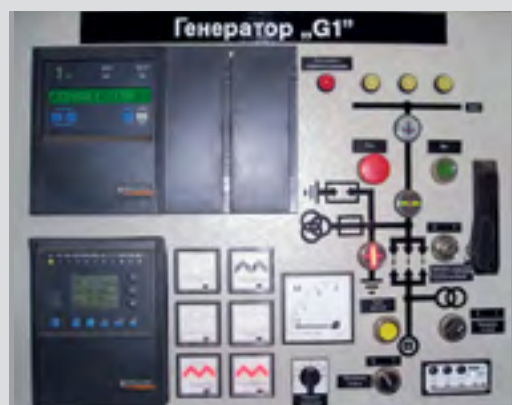
Рис. 5.17. Мнемосхема шкафа генератора
