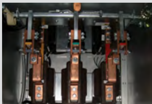
Рис. 7.18. Размещение двух групп ТТ в отсеке присоединений
