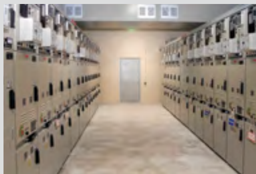
Рис. 1.3. РУ 10 кВ электросетевой ПС
