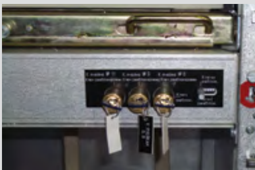
Рис. 10.5. Замковая блокировка измерительного шкафа
