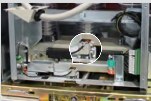
Рис. 10.6. Электромагнитная блокировка привода КВЭ
