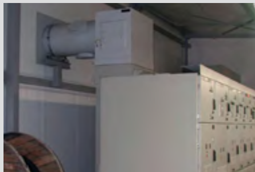
Рис. 8.1. Организация ввода от токопровода
