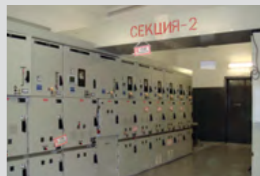
Рис. 8.4. Шинный мост
