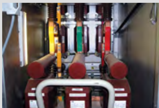
Рис. 7.20. Измерительные ТН в отсеке присоединений
