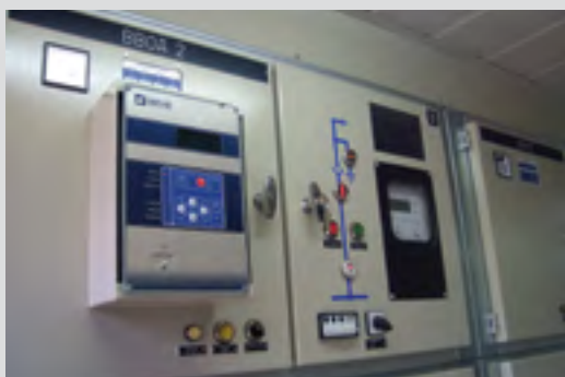
Рис. 9.1. Шкаф КРУ с МПЗ типа БМРЗ
