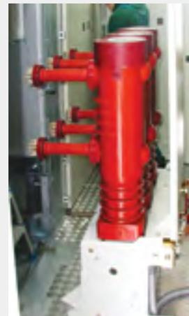
Рис. 10. Выдвижной элемент в ремонтном положении
