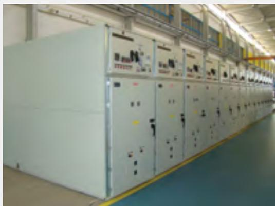
Рис. 2. Распределительное устройство на базе шкафов КРУ D-40P
