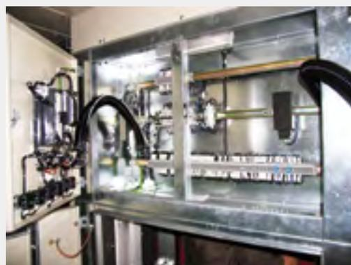
Рис. 12. Отсек вспомогательных цепей
