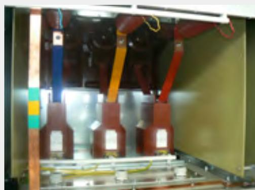
Рис. 11. Отсек присоединений
