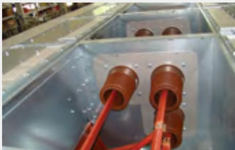
Рис. 6. Отсек сборных шин при снятых клапанах сброса давления
