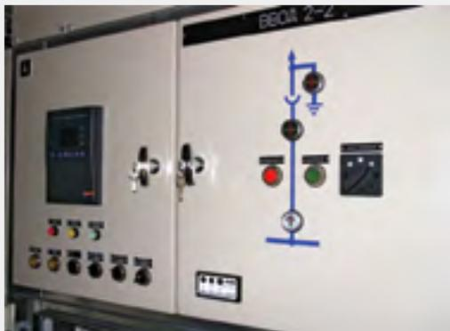
Рис. 13. Мнемосхема шкафа ввода
