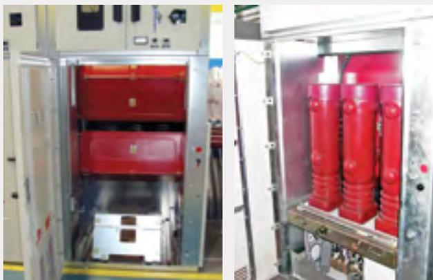
Рис. 7. Отсек выдвижного элемента
