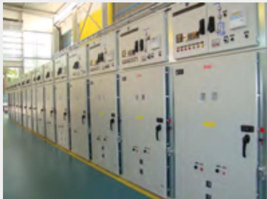
Рис. 1. Общий вид шкафа КРУ серии D-40P
