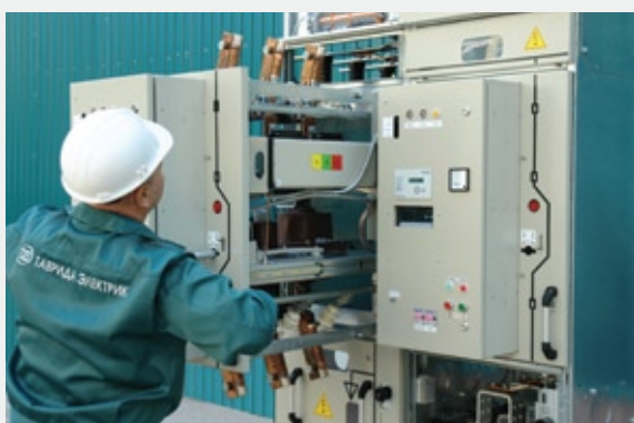
Рис. 5.4. Шинный и линейный разъединители
