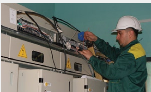
Рис. 5.14. Прокладка транзитных цепей
