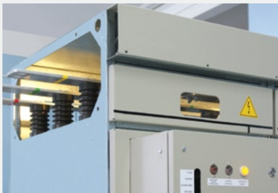
Рис. 5.2. Отсек сборных шин
