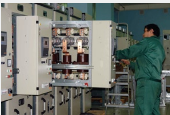
Рис. 5.3. «Ремонтное» положение моноблока
